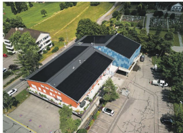
Die neue Indach-Anlage auf dem Süd- und Norddach des Werkgebäudes.
